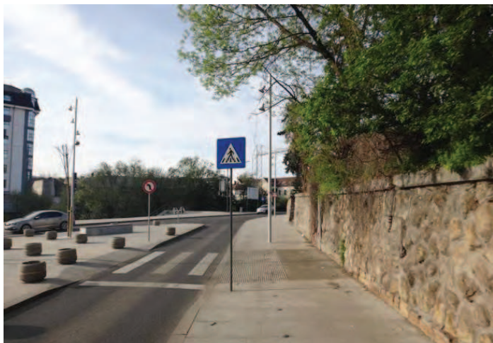
Fig. 17. Someș, malul stâng. Zona cartierului Grigorescu, strada Dragalina, aproape de intersecția cu strada Horea – pistă de biciclete cu sens unic, cu utilizare obligatorie, având în mijlocul ei un stâlp metalic și zero spațiu lateral de siguranță față de trotuar, forțând deci biciclistul să intre ilegal pe trotuar pentru a evita obstacolul dacă îl observă la timp. Se observă și contradicția dintre indicator și marcaj, care, deși intenția e să delimiteze pista, nu e corespunzător cu modelul de marcaj prevăzut de legislația rutieră
