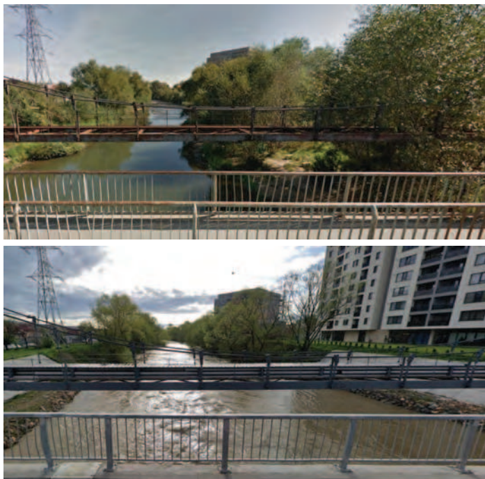
Fig. 4. Malurile Someșului, înainte și după modernizarea Podului Porțelanului, septembrie 2011 (sus), aprilie 2022 (jos). Se observă eliminarea vegetației ripariene și betonarea malurilor, adică infrastructură gri de amenajare a râurilor, fără subtraversare pietonală și ciclistă. Sursa: Google Maps
