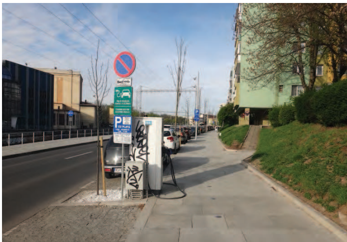
Fig. 18. Someș, malul stâng. Zona cartierului Grigorescu, strada Dragalina – pistă de biciclete cu un sens, la nivelul trotuarului, dar fără delimitare cu marcaj rutier conform legii, ci cu un șir de butoni metalici greu vizibili și care nu produc efecte juridice și, deci, în contradicție cu indicatorul de pistă separată de biciclete și pietoni. În plus, cablurile de încărcare pentru autoturisme stau în buclă în interiorul pistei, ca niște adevărate capcane
