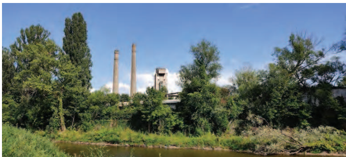
Fig. 37. Malul Someșului în zona Platformei Carbochim, 2023. Foto: Adriana Măgerușan
