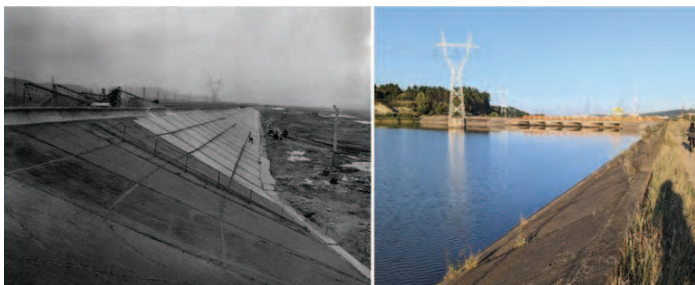
Fig. 32. Lacul de acumulare și centrala hidroelectrică Florești II: șantierul din 1985 (arhiva Minerva) și situația actuală
