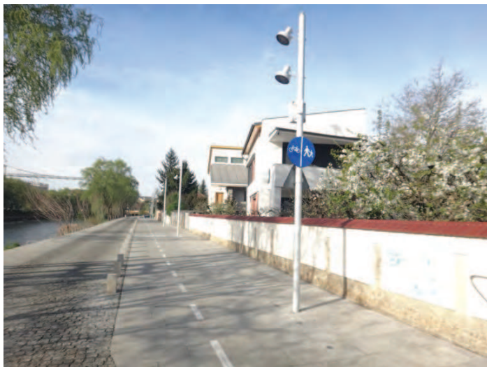
Fig. 15. Someș, malul stâng. Zona cartierului Grigorescu, strada G. Muzicescu – pistă de biciclete cu lipsă de delimitare față de fâșia pietonală, dar cu marcaj de delimitare a sensurilor de pedalat. La ambele capete ale străzii, însă, sunt amplasate indicatoare de „zonă pietonală”, ceea ce face inutilă delimitarea fizică cu blocuri de piatră a zonei pavate cu piatră cubică de zona dalată și este în contradicție și cu indicatorul de pistă comună pentru biciclete și pietoni
