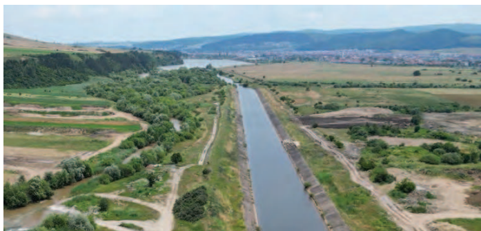
Fig. 37 (sus). Degradarea luncii inundabile prin extinderea dereglementată a construcțiilor în zona Florești
