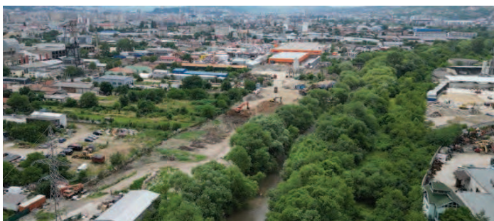
Fig. 39 (sus). Continuarea lucrărilor de regularizare a Someșului în Apahida, completate de etalarea pe orizontală cu hale de producție și suprafețe sigilate vaste în fosta luncă inundabilă
