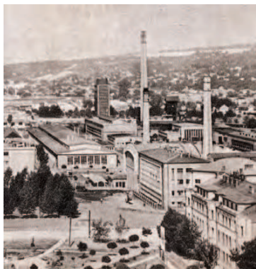
Fig. 11. Fotografie din anul 1963 dinspre Piața 1 Mai, cu clădirile semnificative din Ansamblul Carbochim, clădiri existente încă în anul 2024, chiar dacă mascate de clădiri parazit. Sursa: https://a60194.wixsite.com/digitalcluj/copia-armatura (detaliu)
