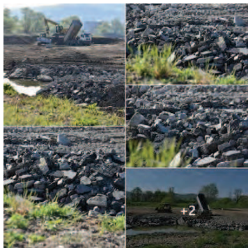
Fig. 17. „În decembrie 2021, Compania de Apă Someș a atribuit contractul «Reabilitarea sursei subterane Florești» unei asocieri formate din companiile Dimex 2000 din Bistrița și CONSOLA GRUP CONSTRUCT din București. Valoarea contractului este de 66.584.000 de lei, parte din sumă fiind din fonduri europene. În cadrul lucrărilor au fost folosite deșeuri din construcții, asfalt frezat etc, care sunt îmbibate cu uleiuri și hidrocarburi. Aceste substanțe extrem de toxice pentru sănătatea umană se infiltrează în apa din pânza freatică care este captată prin rețeaua respectivă de Compania de Apă Someș și, ulterior, livrată populației”. Text și foto: Răzvan Robu/ Anca Mihael. Detalii pe Clujul Civic, investigația fiind ștersă de pe siteul Gazeta de Cluj, pentru care a fost realizată investigația: https://www.facebook.com/groups/clujulcivic/permalink/7228937090545422/
