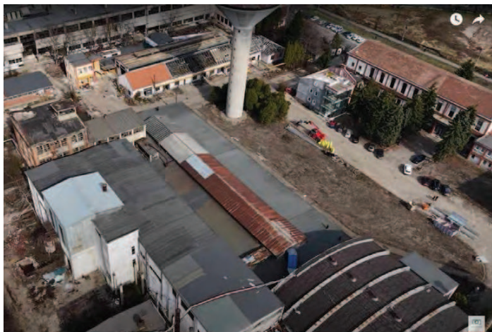
Fig. 38-39. Zonă verde din interiorul Platformei Carbochim – mai 2022 (sus), februarie 2024 (jos). Înainte/ după, imagini din dronă. Potrivit proiectului, copacii care pot fi păstrați sunt extrași, plantați într-o pepinieră, apoi aduși înapoi și plantați din nou. Zonele verzi din interiorul platformei existau din prima fază a platformei, la fel cum Piața 1 Mai era amenajată cu scuaruri verzi încă din anii '60. Sursa: Capturi de ecran dintr-un video Legat de Cluj
